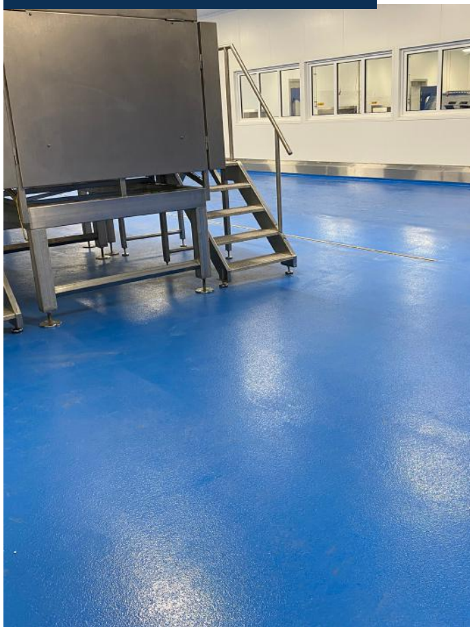
3010 m 2 Stonclad UR installer
